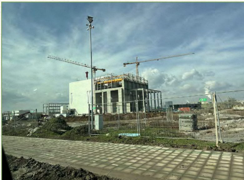
Slika 44: Spalionica u izgradnji, ELIXIR d.o.o. Prahovo (izvor privatna arhiva)
