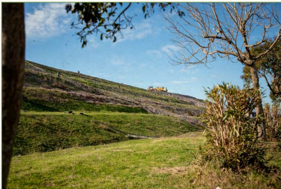
Slika 10: Izgled bedema na sanitarnim kadama 1, 2 i 3 (Izvor Deponija d.o.o.)
