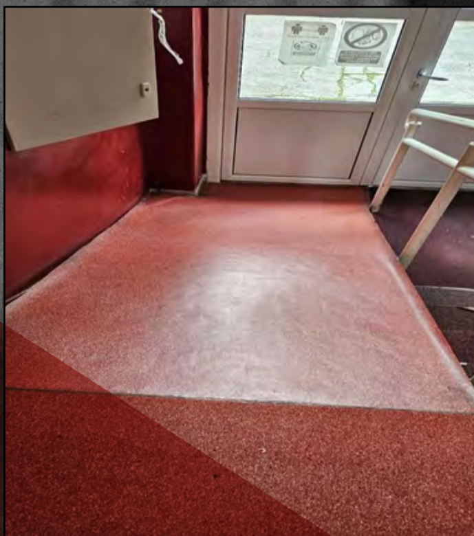
(rampa u unutrašnjosti zgrade OB Nikšić - ispred prijavnice - nagib; izvor: GA)
